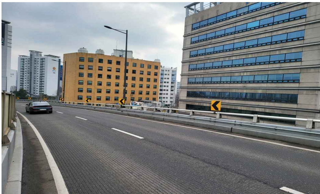
이수고가 전경사진(C-Line 상부)
