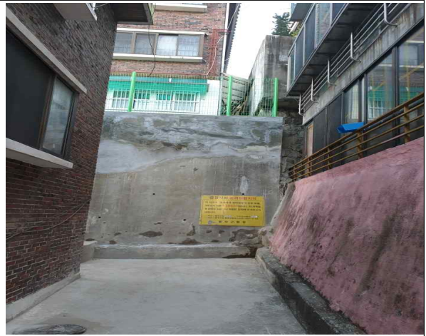
공사시행완료 -옹벽상부 철거 재시공, 하단 배수구 설치
