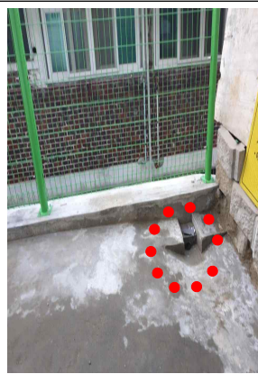
공사시행완료 - 옹벽상단 배수구 설치, 바닥 방수
