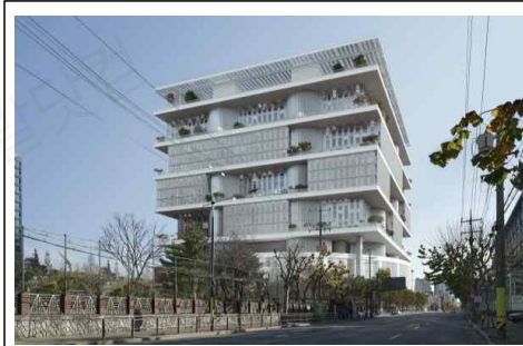
성수동 이마트 부지 개발 (공사 중)
